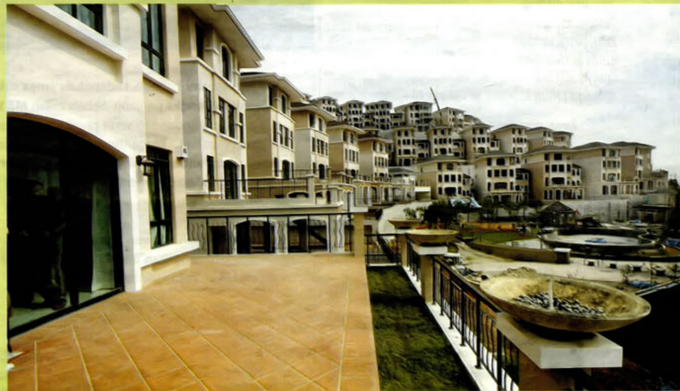
PROJEK Moonlight Bay yang masih dalam pembinaan akhir.
